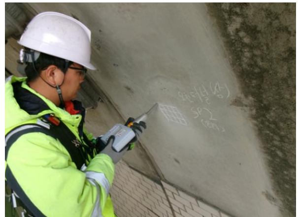
터널 라이닝 비파괴시험
