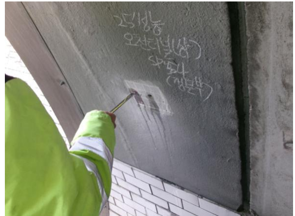
탄산화 깊이 측정
