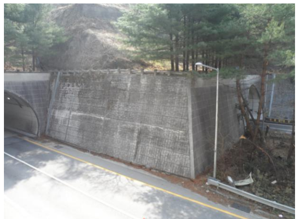
옹벽, 사면부 전경
