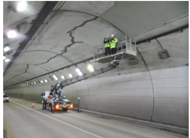
고소점검차를 이용한 근접조사
